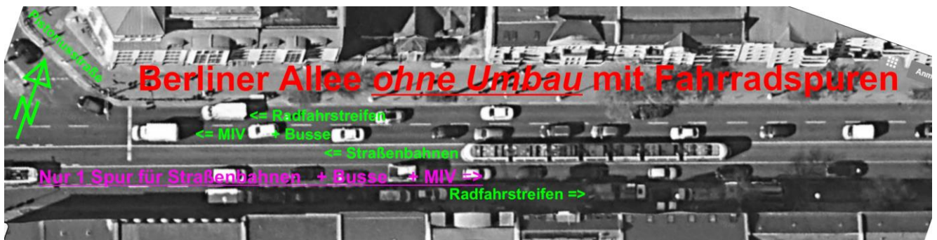
Abbildung 1: Mit Erneuerung der Gleise in gleicher Lage und Einrichten von Fahrradstreifen verbleibt zwischen Pistoriusstr. und Haltestelle „Weißer See“ stadtauswärts nur eine Spur für ÖPNV und Kfz-Verkehr.
